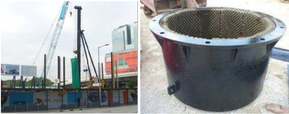
图 10. 于打桩时使用隔音屏障及锤盾
