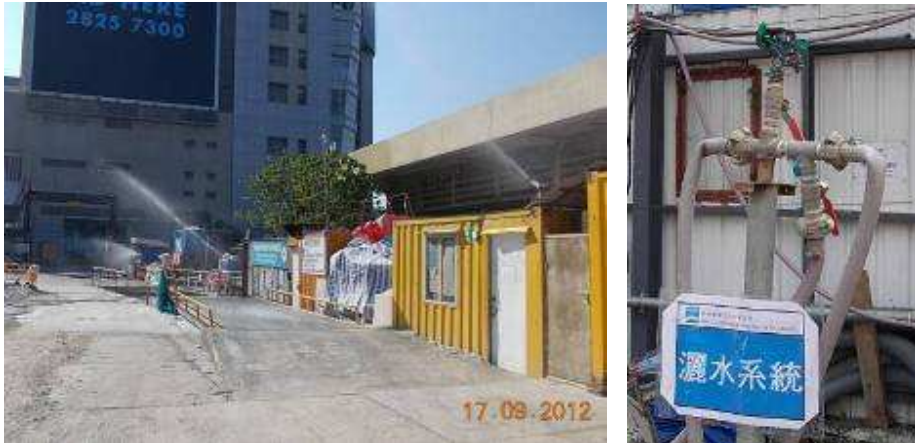
图1. 使用喷雾洒水系统于主要路面洒水
