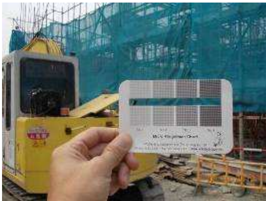
图4. 使用林格曼图进行机械黑色烟雾监测
