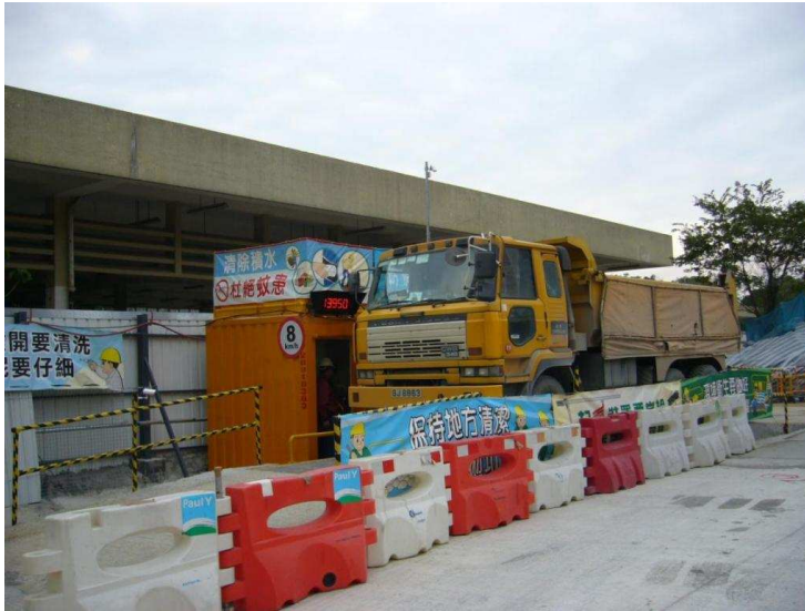
图 15. 磅桥及 CCTV 系统
