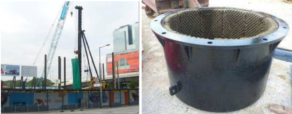
圖 10. 於打樁時使用隔音屏障及錘盾
