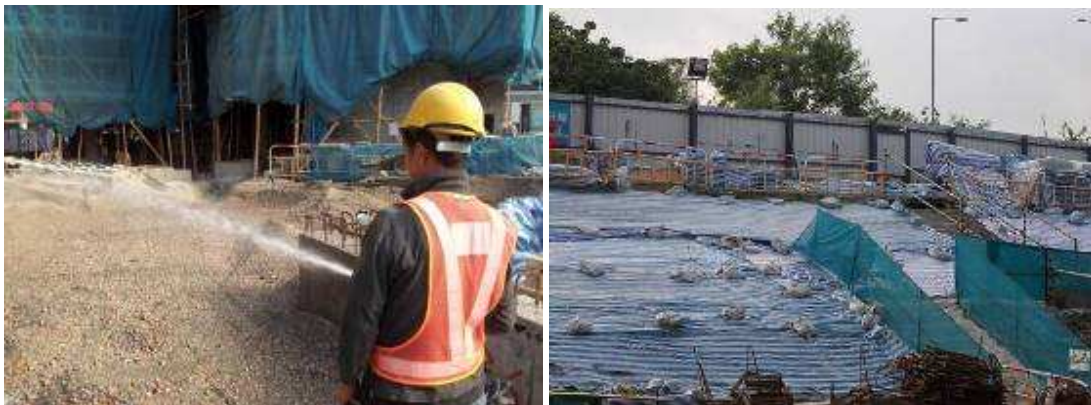
圖 2. 頻繁的在外露的土壤和斜坡灑水
