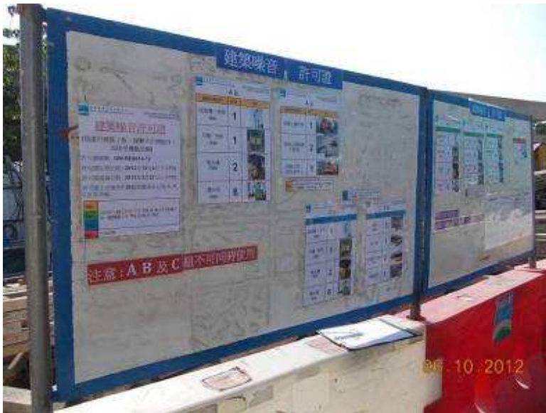
圖 13. 將 CNP 中機動設備的詳細資料張貼於告示板
