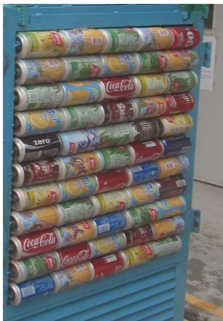
循環再用 (如:發泡膠及汽水罐) 作隔熱用途
