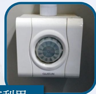
照明系统利用 动作感测开关
