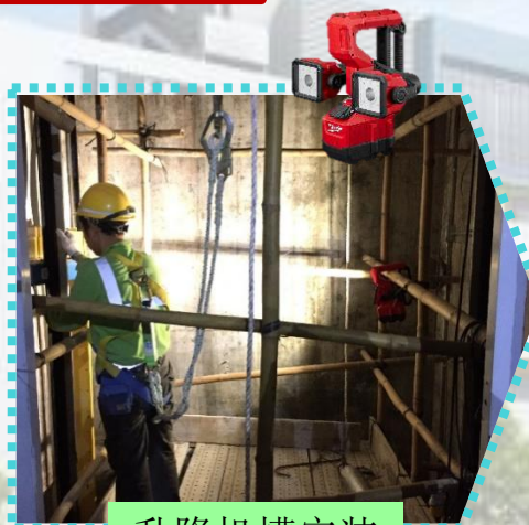
升降机槽安装
