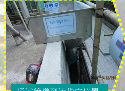
通过管道到达指定位置
