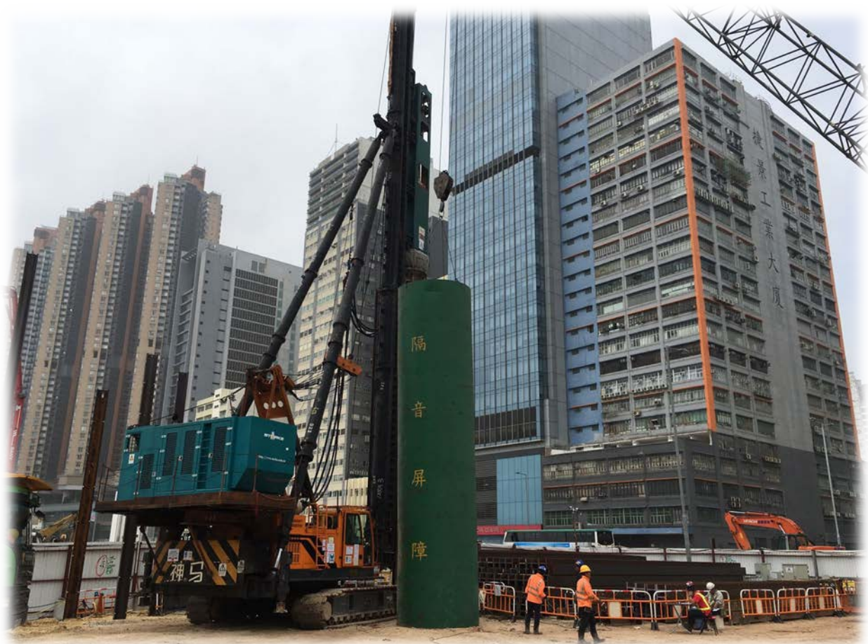
隔音罩用於打樁工序，可減少15 dB (A) (由經過認證的實驗室測量)
