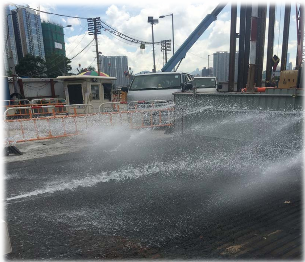
使用回收的废水进行车轮清洗
