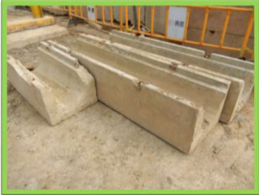
預製U渠以減少廢石矢產生
