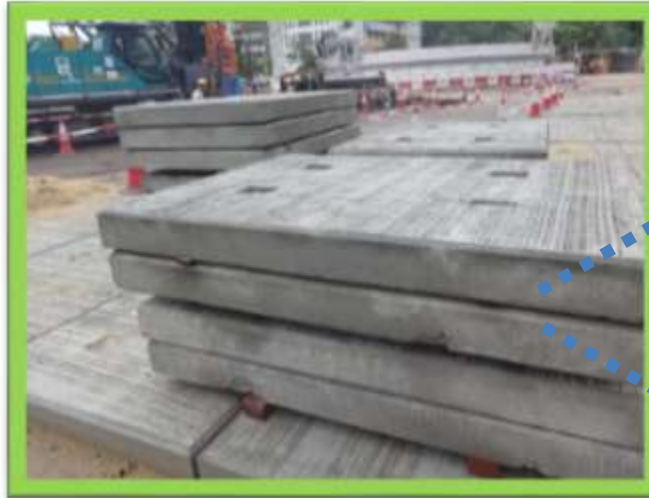
预制石矢板铺设路面以 减少尘埃产生
