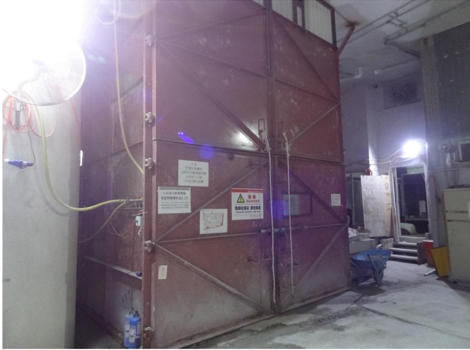
內建自動灑水系統的全密封式垃圾槽
