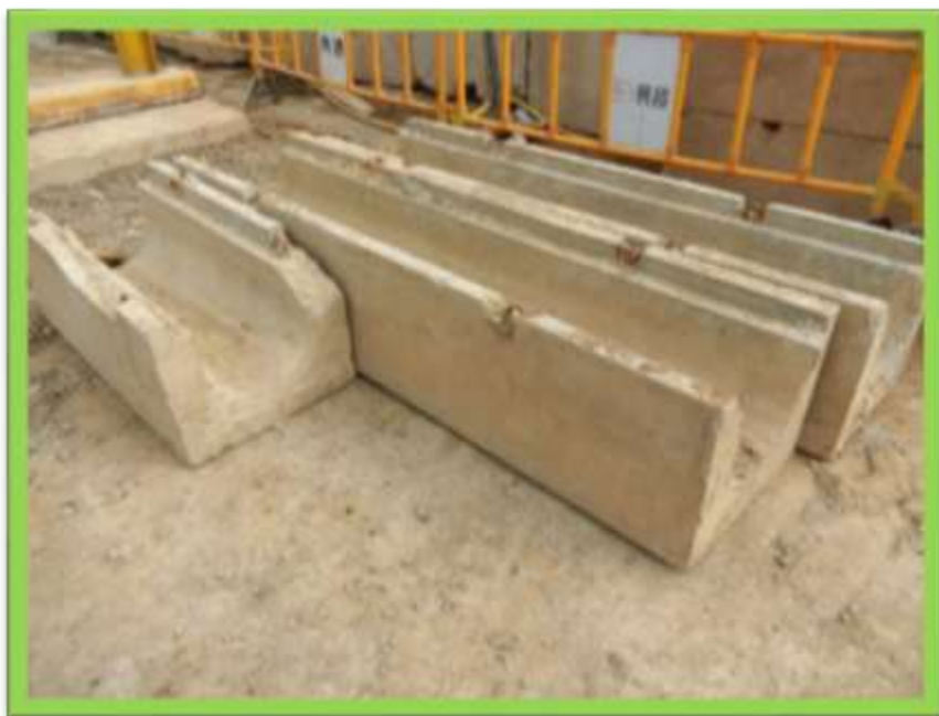
預製U渠以減少廢石 矢產生
