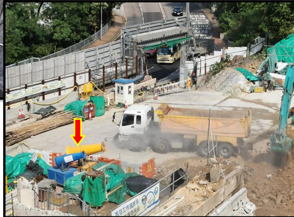
防塵霧炮系統(可以透過遙控器操作)會使用於地盤平整工序，以達到抑制塵埃的效果。
