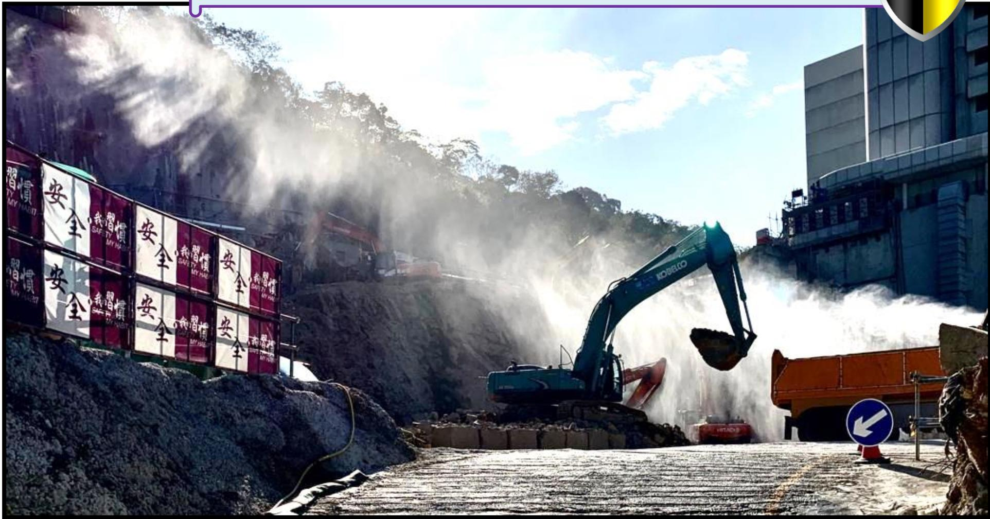
防塵霧炮系統(可以透過遙控器操作)會使用於地盤平整工序，以達到抑制塵埃的效果。
