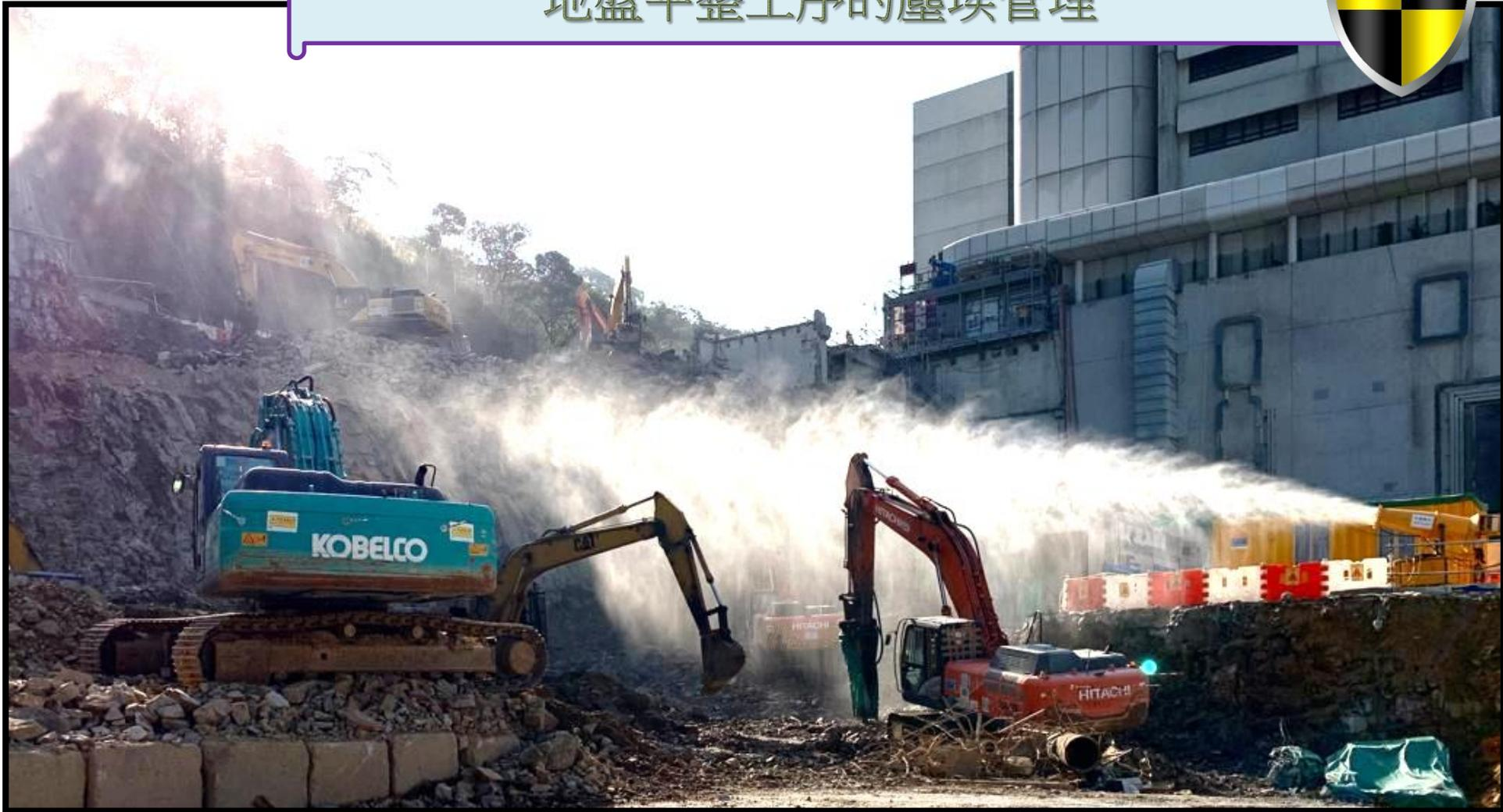
防塵霧炮系統(可以透過遙控器操作)會使用於地盤平整工序，以達到抑制塵埃的效果。
