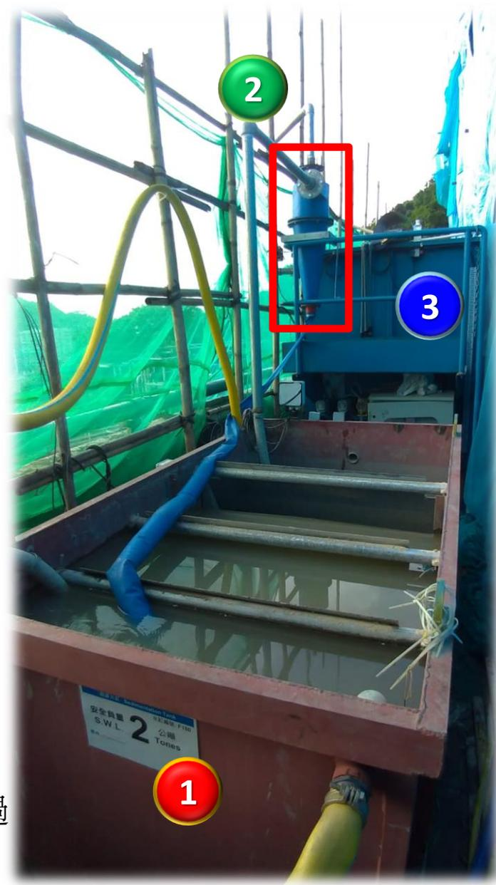
強化沉澱缸，並加設「渦流式分離器」，以增加「物理過濾」的效果，減輕化學過濾設施的負擔，同時改善水質。
