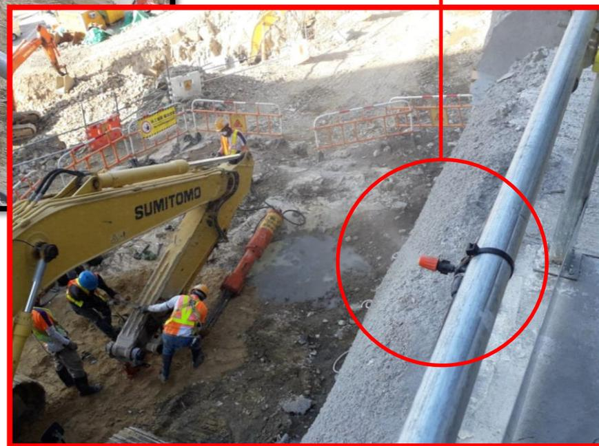
在圍欄處安裝足夠的「霧化頭」，挖掘工序進行時釋放水霧，以達致抑制塵埃的效果。
