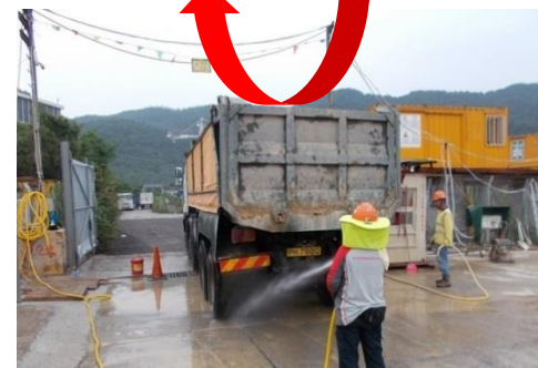
洗车池污水循环系统
