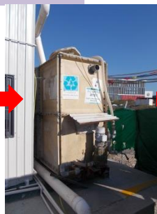
使用雨水收集缸，作洗地水用途
