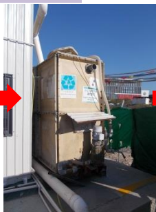
使用雨水收集缸，作洗地水用途
