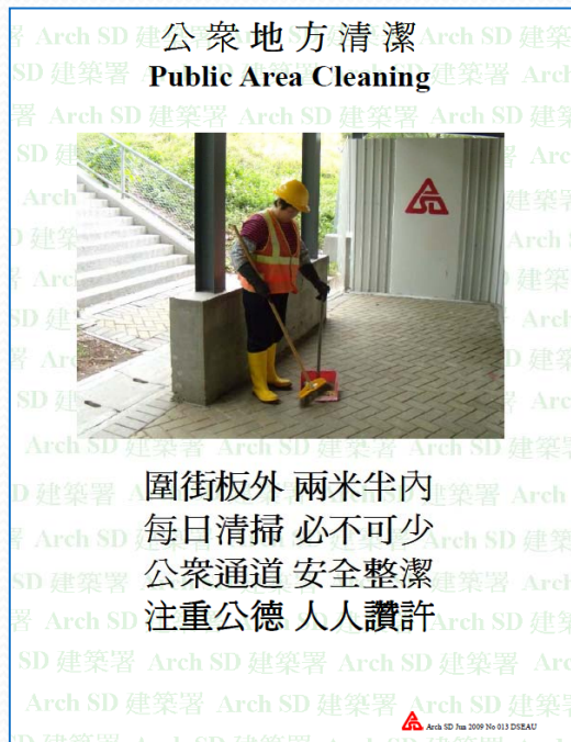
(一) 工地整潔管理
