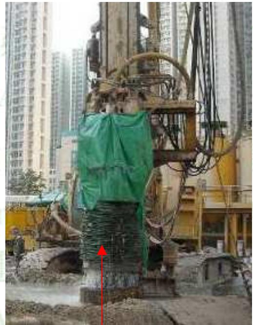
鑽樁機的鑽桿上安裝了伸縮罩，有防塵及減少噪音功能，亦可避免污水濺出
