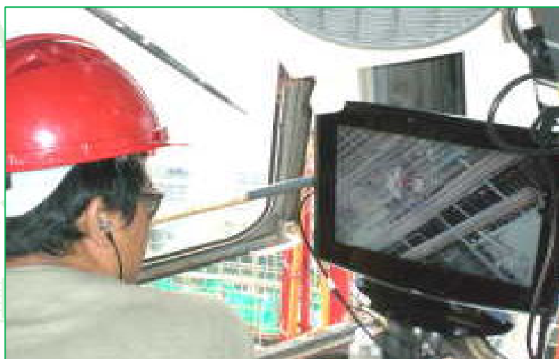
閉路電視輔助吊運過程
