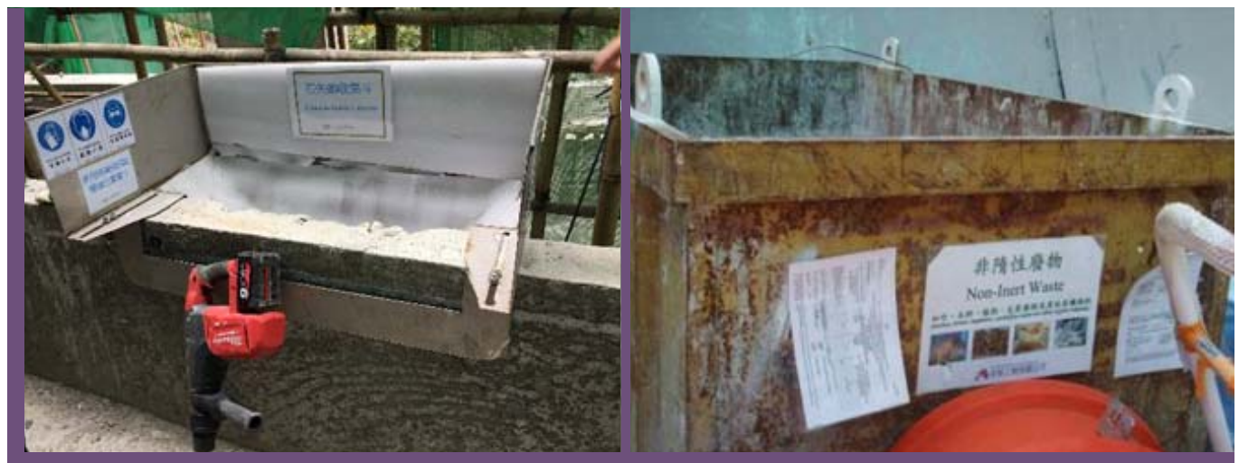
拆建物料即场分类以便回收重用/弃置 1,3
