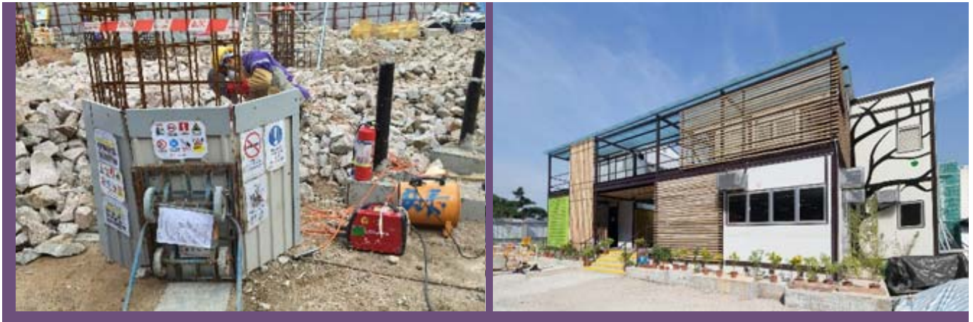
由废旧物料制成的移动焊接机（左）和临时外墙（右） 1
