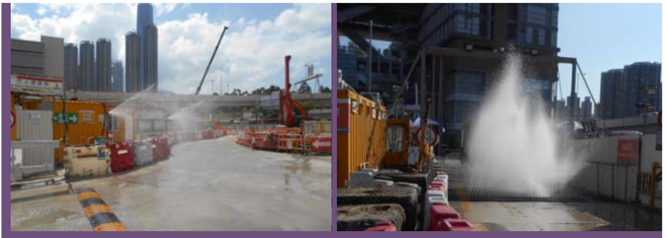
中水自动洒水系统（左）和中水车轮清洗系统（右） 2
