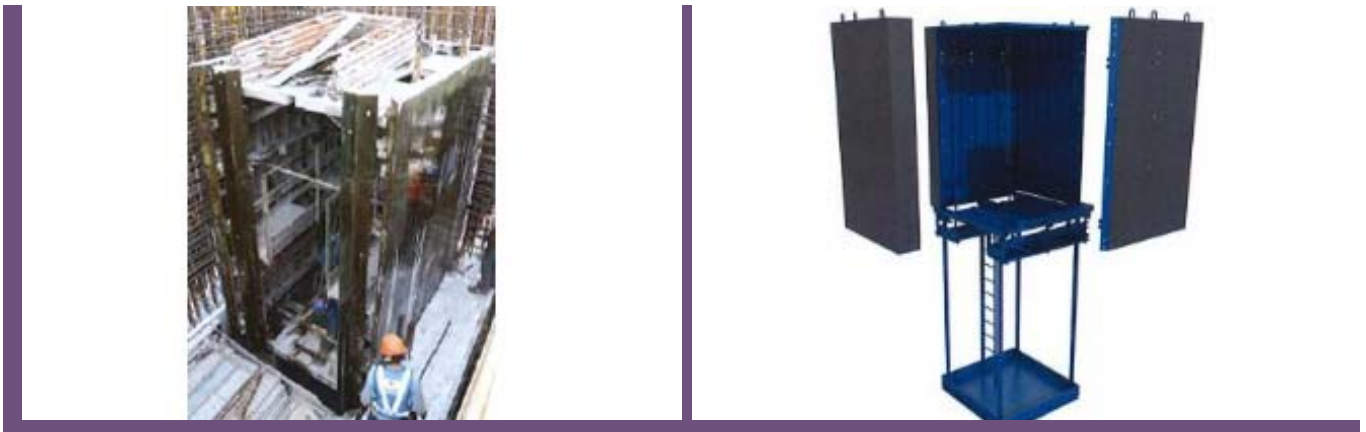
利用金属模板兴建电梯井以减少建筑材料的消耗 2
