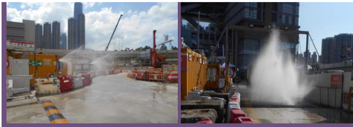
中水自動灑水系統（左）和中水車輪清洗系統（右） 2
