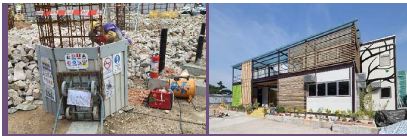
由廢舊物料製成的移動焊接機（左）和臨時外牆（右） 1
