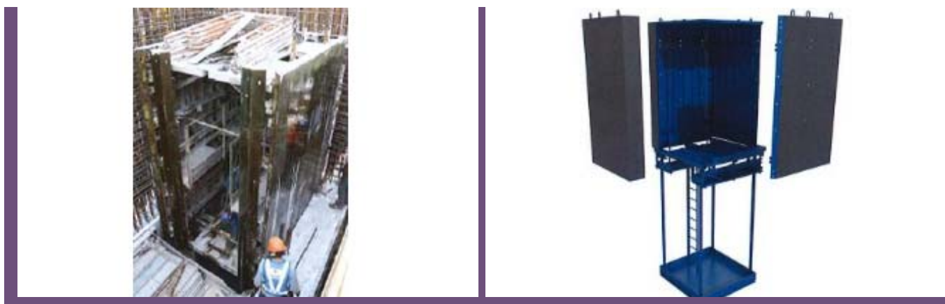
利用金屬模板興建電梯井以減少建築材料的消耗 2
