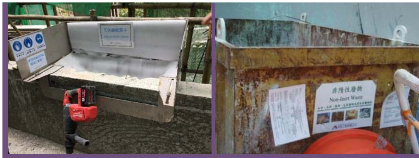
拆建物料即場分類以便回收重用/棄置 1,3
