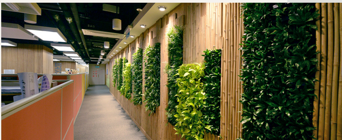
建筑署建业中心文楼一楼翻新工程
