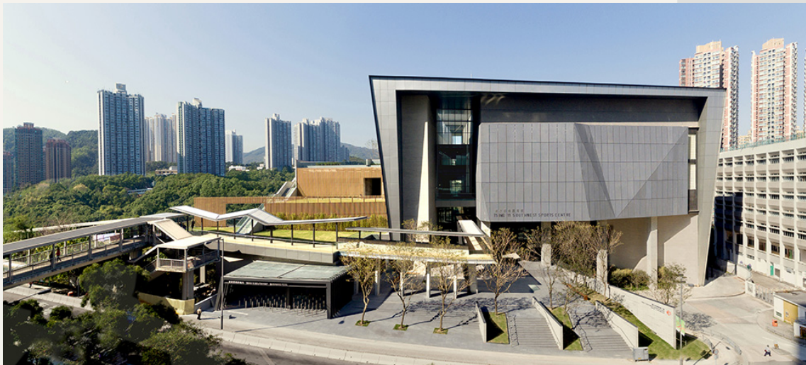
青衣西南康体大楼
