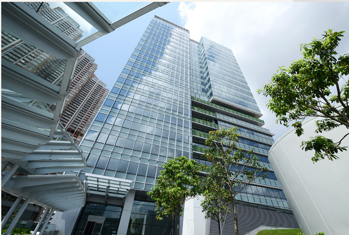
工业贸易大楼
