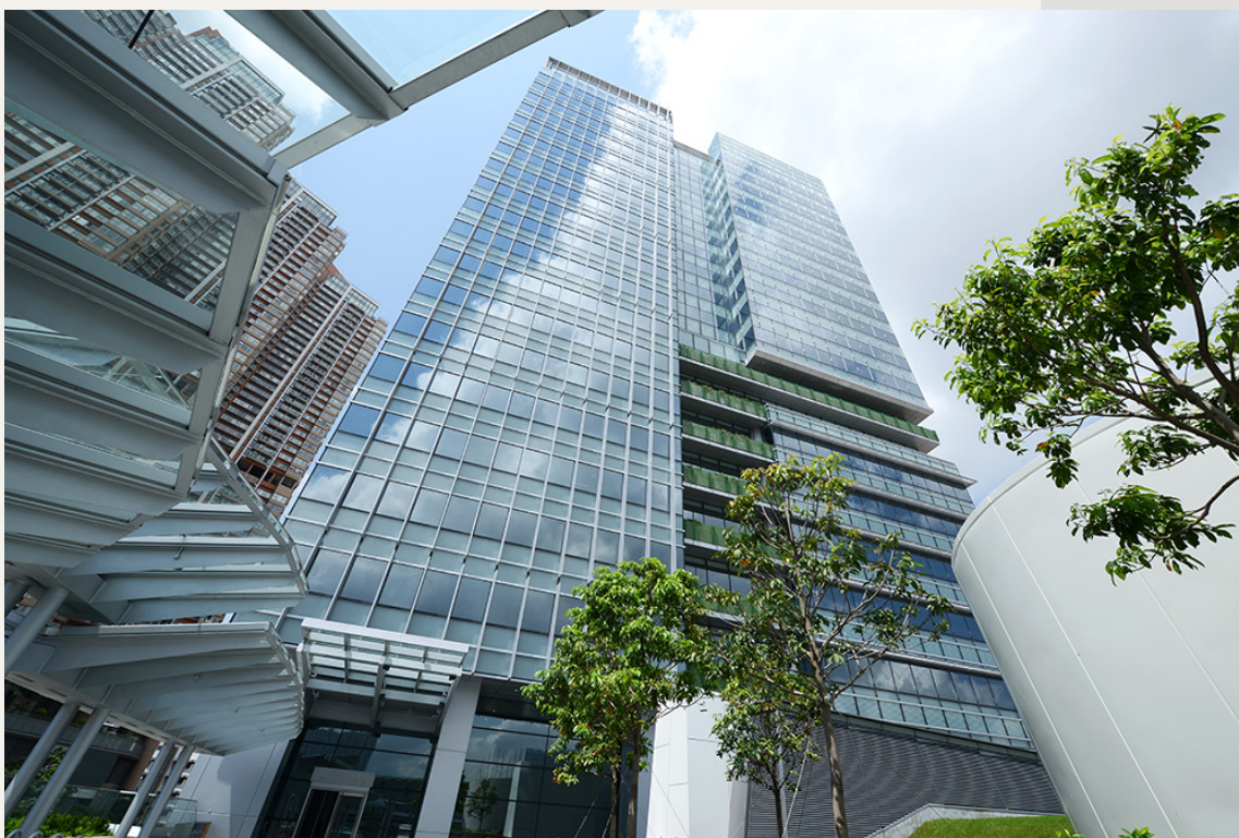
工业贸易大楼
