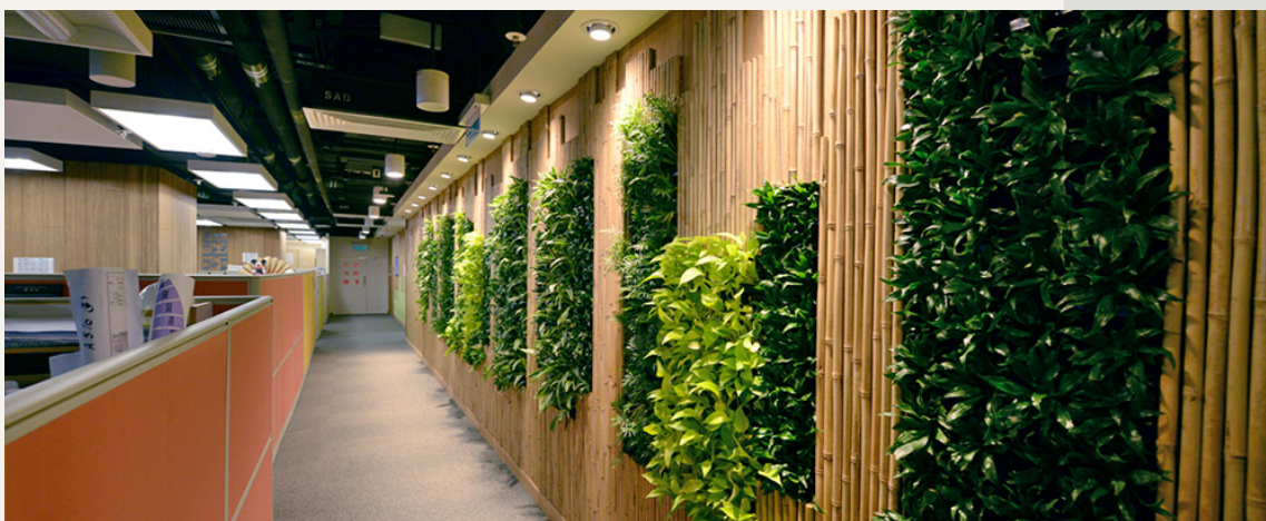
建築署建業中心文樓一樓翻新工程
