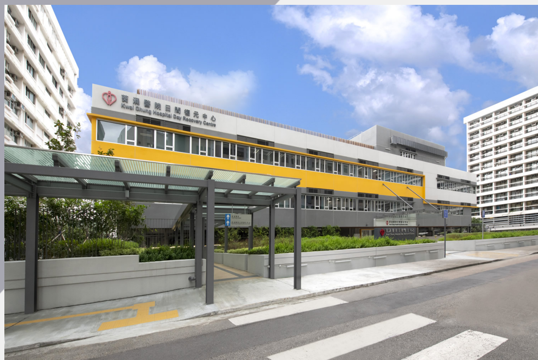
葵涌醫院重建工程第一期的調遷大樓設計簡潔實用
