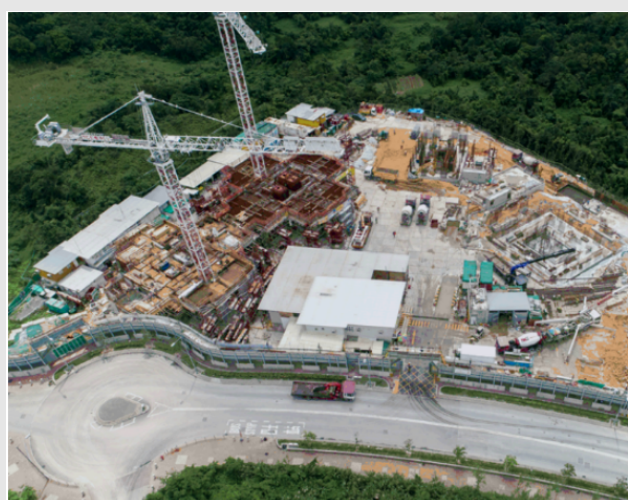
將軍澳百勝角消防處紀律部隊宿舍建築工地
