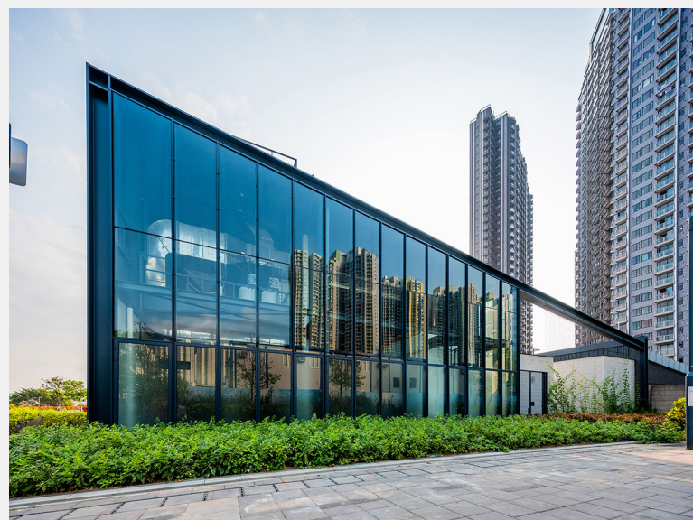
落地玻璃牆引入天然光線
