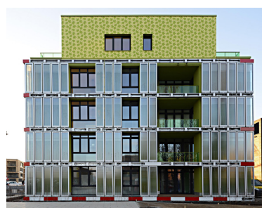
▲ Microalgae Bioreactive Façade (MBF)
